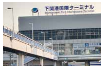
国際航路が発着する「下関港国際ターミナル」。市民会館の近くにある
