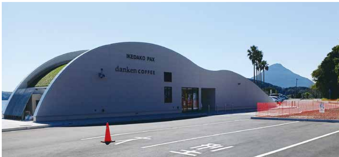
イッシーの背中？ 波打つ屋根を持ついけだ湖パックスの建物
